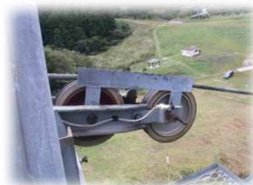
(リフト索輪の点検整備)
