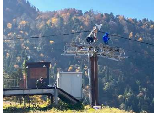
(リフト索輪の点検整備)
