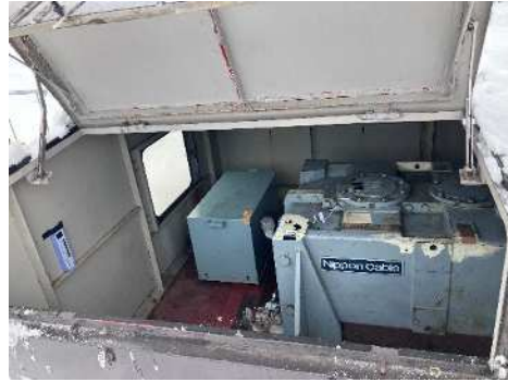
(リフト減速機の点検整備)
