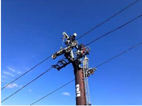
(リフト索輪の点検整備)
